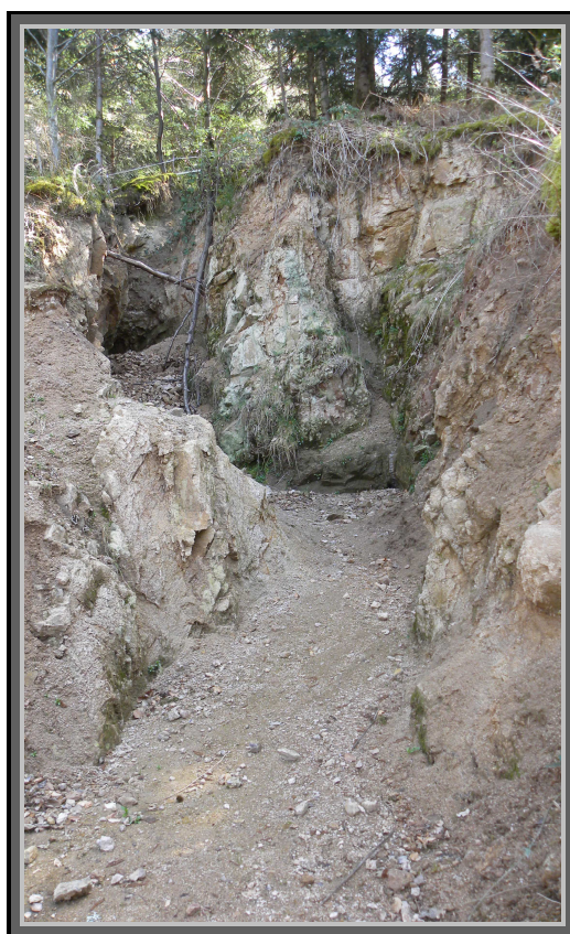
Vue partielle des travaux en 2014
